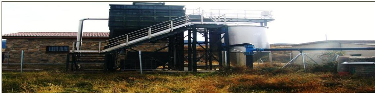
El agua captada se hace llegar hasta la planta de Tratamiento de Agua Potable (ETAP) situada en el paraje Cepones para ser tratada con técnicas de filtración y desinfección y de esta manera asegurar la calidad exigida por las autoridades sanitarias.
